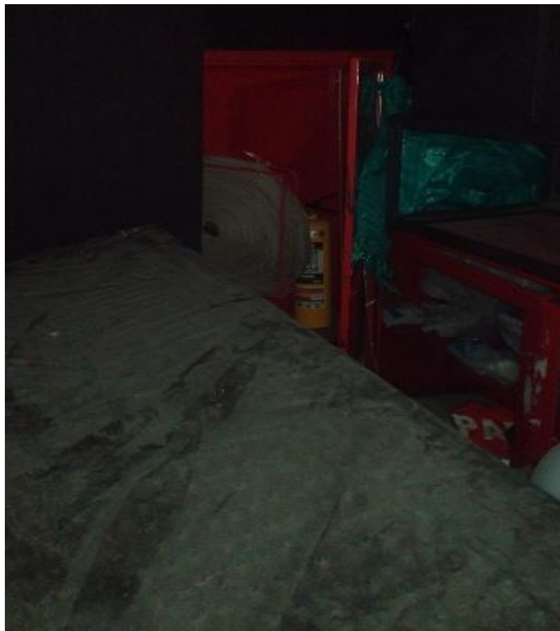
Ilustración 16 Gabinete red contra incendios, escenario, costado norte. Se evidencia el difícil acceso en caso de
